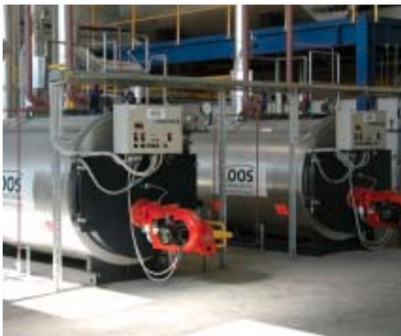
Два паровых котла высокого давления UNIVERSAL U-HD для производства насыщенного пара
