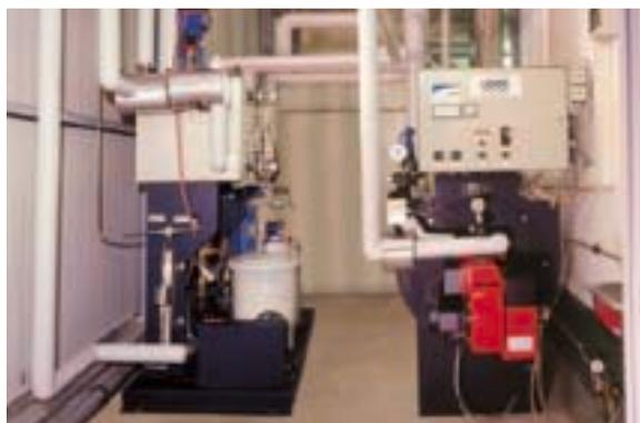
Котел Dampfix DF с деаэрационным модулем WSM-T
