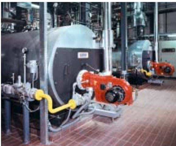
Два паровых котла низкого давления UNIVERSAL U-ND с модулируемыми газовыми горелками
