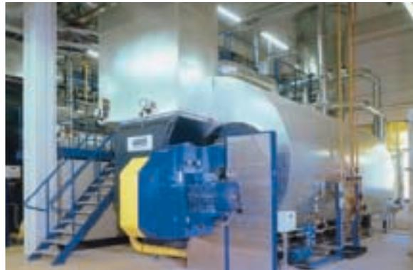
Паровой котел высокого давления UNIVERSAL UL-SX с пароперегревателем
