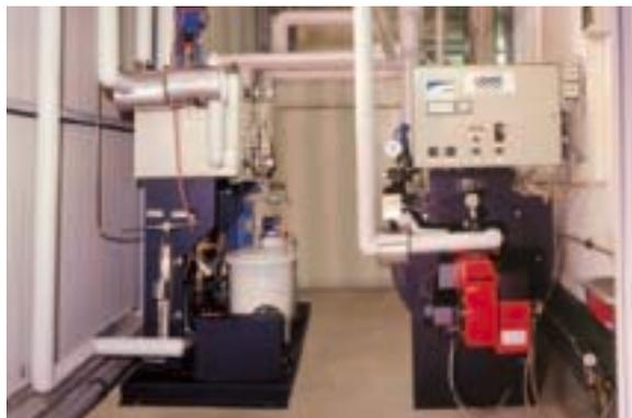
Котел Dampffix DF с деаэрационным модулем WSM-T
